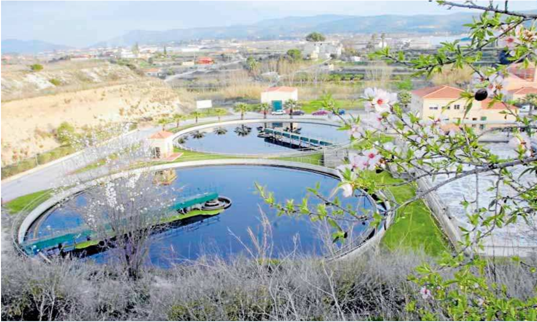
◀ Apta para riego. Planta depuradora integral de aguas residuales de Ontinyent-Agullent, con tratamiento terciario. IRENE MARSILLA
