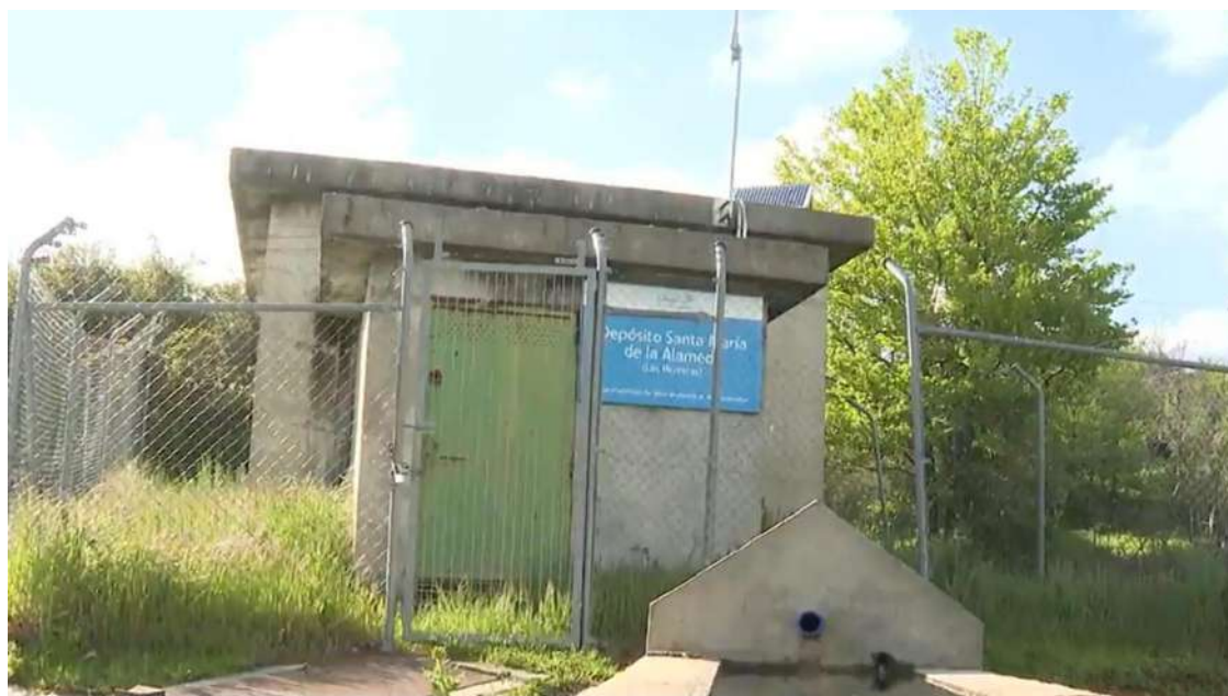
El depósito de agua con el que se abastece el pueblo de Las Herreras.
